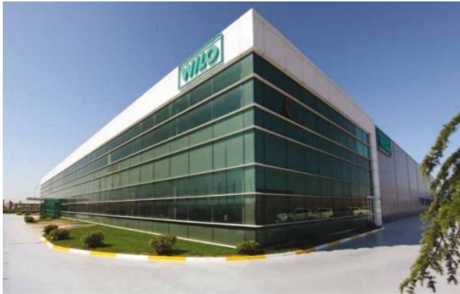
Resim 12. Wilo Pompa Sistemleri Binası (Wilo, 2020)
