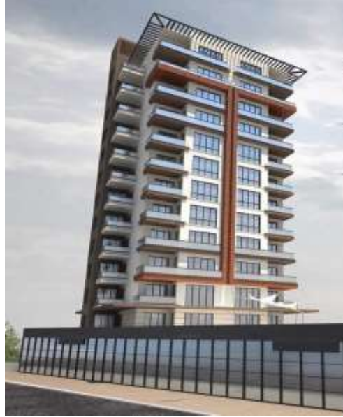
Şekil 1. Ölçüm yapılan bina
